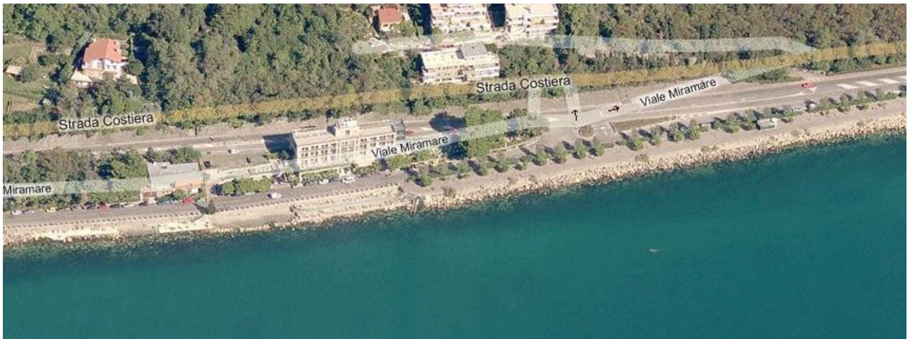
Piattaforma in località “Bivio”
